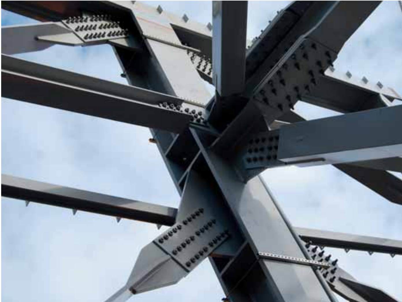
Skruvförband levererade av Bult & Fästteknik AB enligt EN 14399-3 hållfasthetsklass 8.8 till Holmenkollen.
