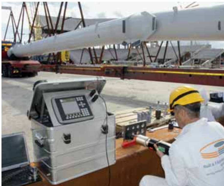
Fästelement och procedurprov levererade av Bult & Fästteknik AB för Ruukki Oys utförande av takkonstruktionen i stål till Fotbollsstadion Swedbank Arena.
