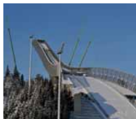
Holmenkollens nya hoppbacke, design Florian Kosche, byggd av Lecor Stålteknik AB Fästelement och procedurprov från Bult & Fästteknik AB.
